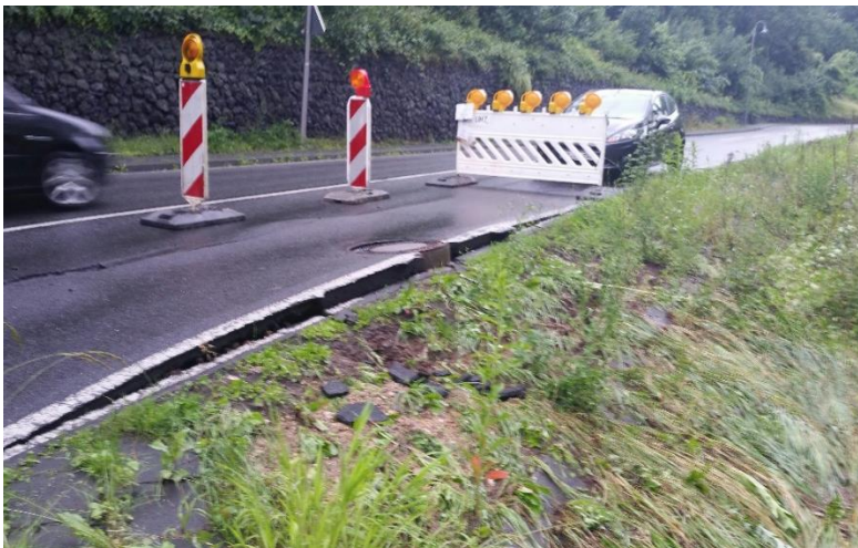
Abbildung 1: Dattenberg, Anhebung eines Kanaldeckels und des Straßenbelags nach Starkregen (VG Linz 2016)
